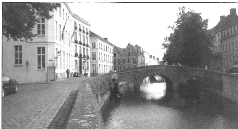
Foto van de Augustijnenbrug (2005), voorkant en achterkant.
